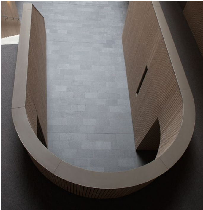
Rondgewalste aluminium muurafdekkap
