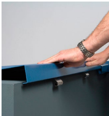
De aluminium muurafdekkap wordt met een simpele beweging over de klikveer heen gedrukt
