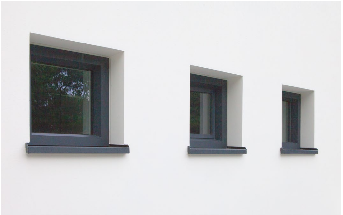
Aluminium kopschotten zorgen voor een perfecte aansluiting van de aluminium raamdorpel op bijvoorbeeld stucwerk
