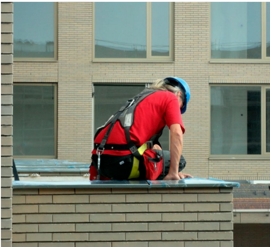
Slim klangersysteem zorgt voor snellere montage en bevordert de duurzaamheid van de aluminium muurafdekkap
