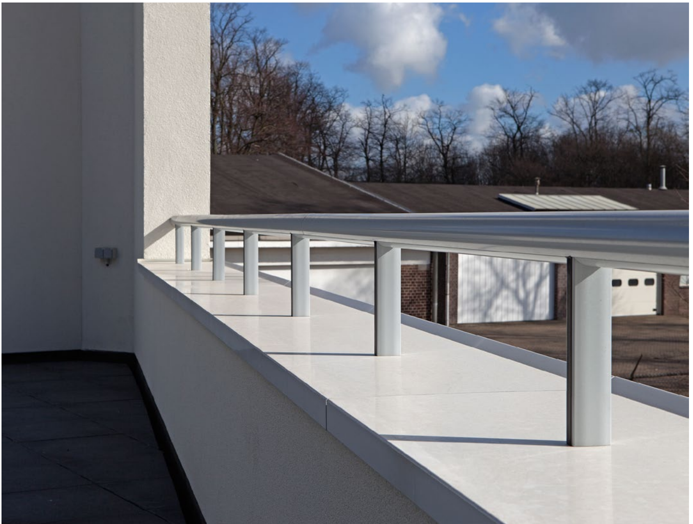
Het klanksysteem zorgt ervoor dat de aluminium muurafdekkap strak en glad blijft
