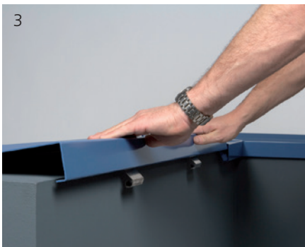
3 De muurafdekkap wordt over de RVS-veer gedrukt.
