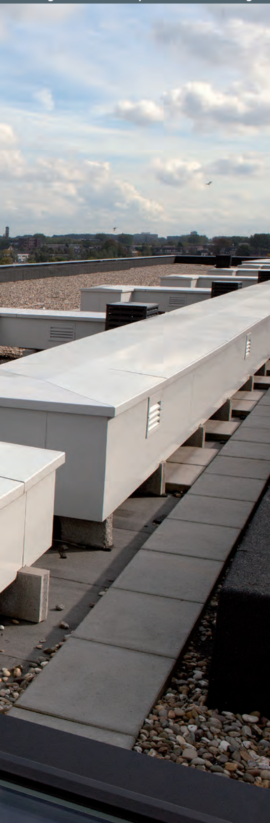
Coffrages sur mesure pour câbles d'énergie
