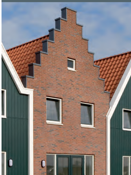
Projet style rétro avec couvre-murs en aluminium en pente
